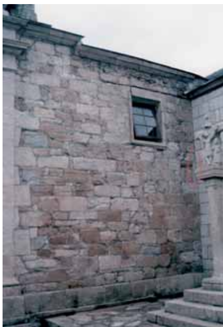
Fig. 7. Lado S de la nave (con indicación de la ventana cegada).
