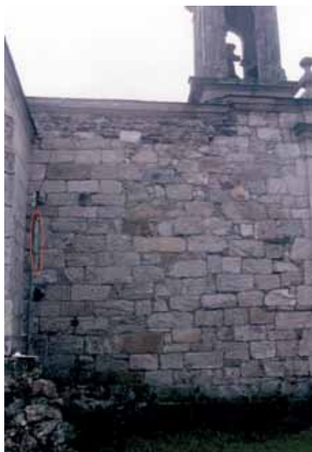
Fig. 6. Lado N de la nave (con indicación de la ventana cegada).
