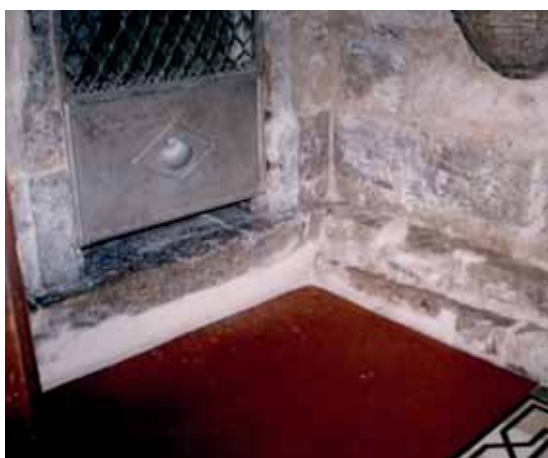
Fig. 10. Encuentro del muro N con el baptisterio al nivel del solado.
